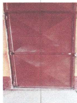
Foto 2: SUSTITUCION DE PUERTAS DE METAL
