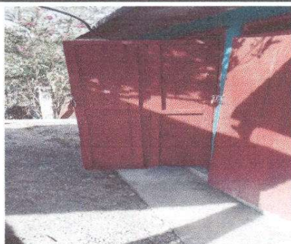
Foto 3: SUSTITUCION DE PUERTAS EN SERVICIOS SANITARIOS
