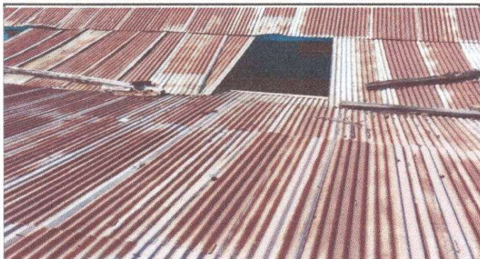
Foto 1: SUSTITUCION DE LAMINA POR LAMINA TROQUELADA CALIBRE 26.
